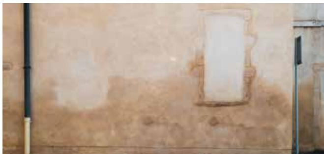
Remontées d'humidité dans un mur : à traiter en priorité.
