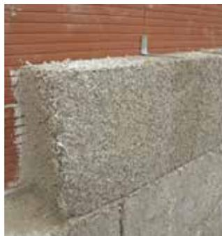
Assemblage au mortier des briques de chanvre.
